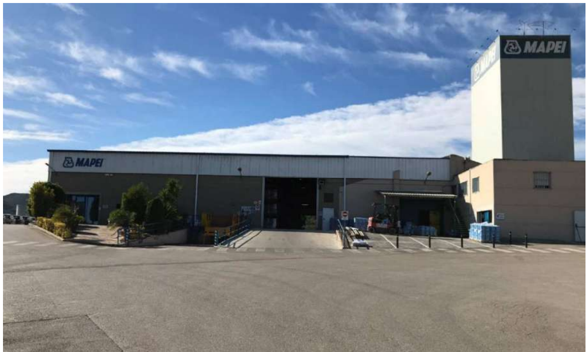
Zona entrada (cobert moll de càrrega) estat actual.
