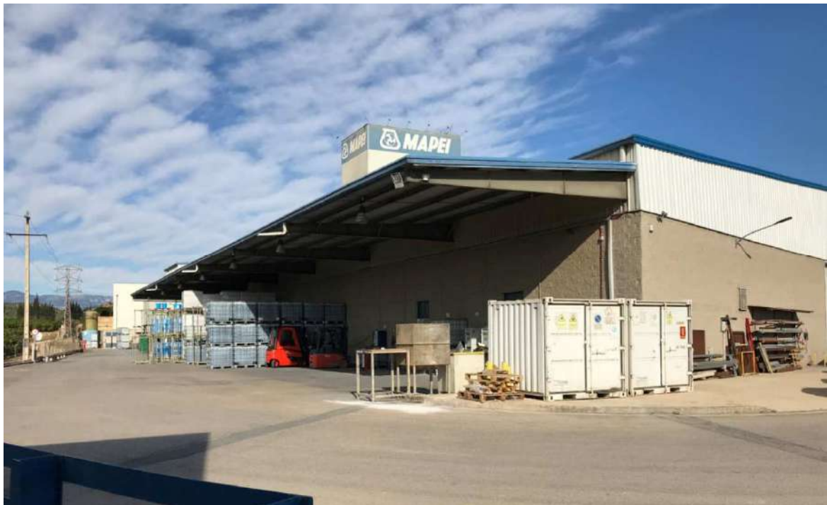
Zona cobert posterior, estat actual.
